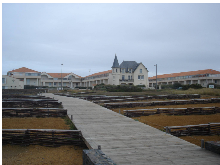
Illustration 14: Vue d'ensemble sur la colonie de la villa Remember à Saint Hilaire de Riez, aujourd'hui.
